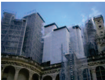
Restauration du Château de Chambord
